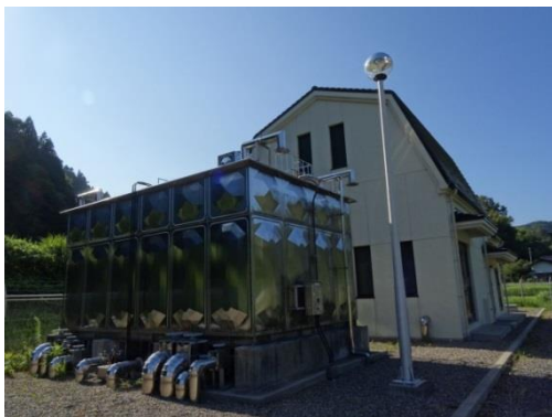
写真 2-4 波見谷浄水場（平成29年度 （2017年度）建設）
