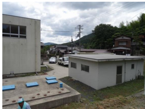
写真 2-5 滝馬浄水場（平成28年度 （2016年度）改修）
